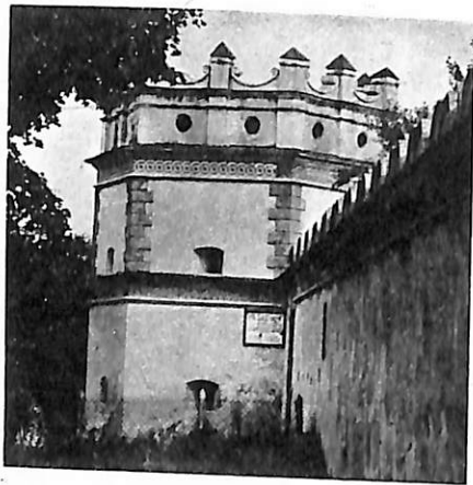
Межирич. Северо-западная башня. 1606—1610
