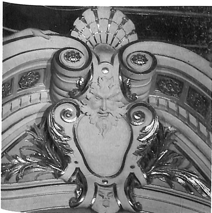
Элемент декора зрительного зала
