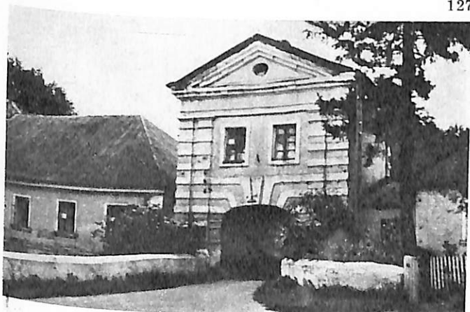
Шпиков. Замок Свейковских. Надвратная башня
