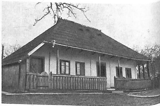
Волока. Жилой дом
