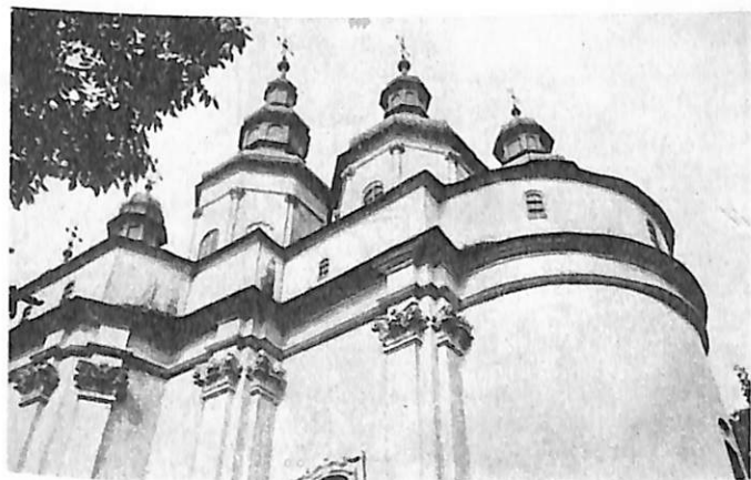
Георгиевская церковь. Фрагмент южного фасада
